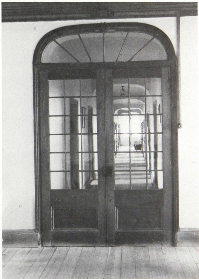
2-34. Saint-Joachim. Château Bellevue. Maison I. 1 er étage. Porte vitrée, à deux battants, séparant le salon des chambres. Par sa forme, cette porte surmontée d'un imposte en anse de panier date vraisemblablement du XIX e siècle. (Voir fig. 2-6). (Photo QQIBC)
