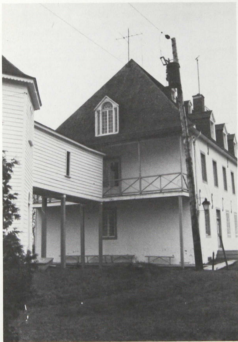
2-19. Saint-Joachim. Château Bellevue. Façade nord, construite en 1870 (photo QQIBC).
