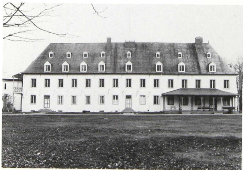
2-15. Saint-Joachim. Vue d'ensemble de la façade arrière (photo QQIBC).
