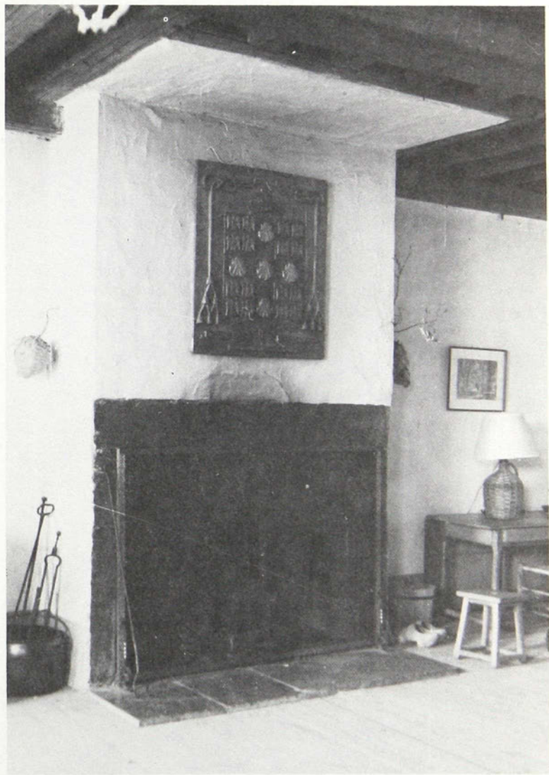
2-36. Saint-Joachim. Château Bellevue. Maison I. Rez-de-chaussée. Le foyer du salon adossé au mur coupe-feu de l'extrémité sud. Au-dessus du foyer, les armoires du Séminaire de Québec (Voir fig. 2-6). (Photo QQIBC)
