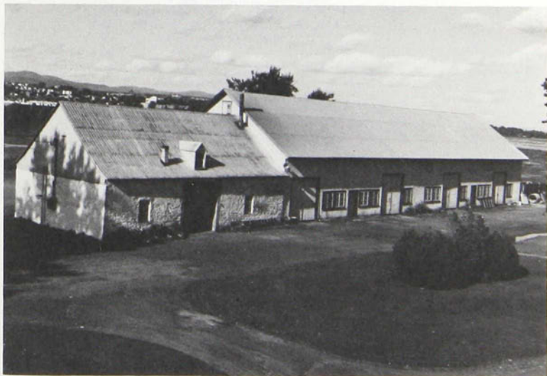
1-29. Québec. Maison Maizerets. Vue de la grange de pierre (photo QQIBC).
