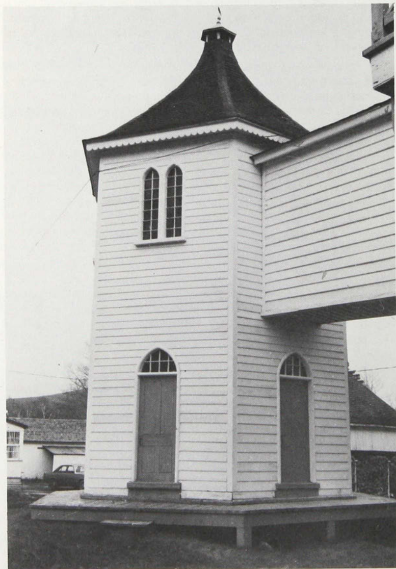
2-21. Saint-Joachim. Château Bellevue. Tourelle annexée, abritant les toilettes, 1870 (photo QQIBC).
