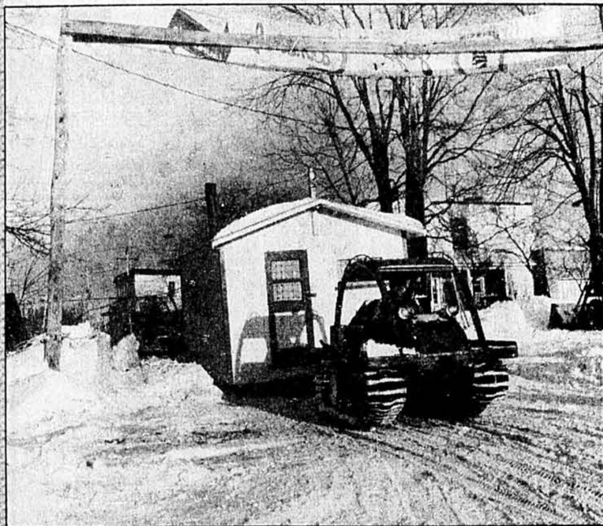
Les ouvriers travaillent jour et nuit afin que les cabanes soient prêtes à accueillir tous les visiteurs.
