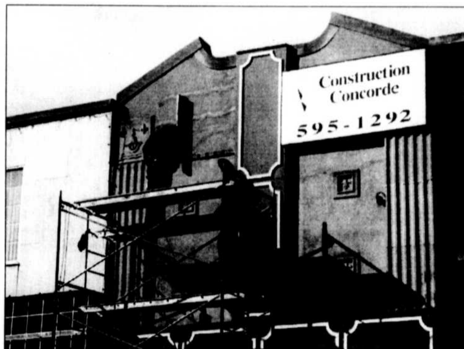
Déjà, des employés s'affairent à rénover la façade du vieil édifice de Promenade du Portage récemment acheté pour 200 000$.
