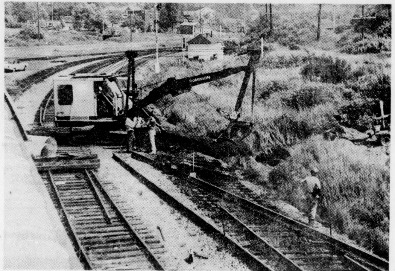
FRANCHIR LES RAILS DU CN, ce n'est pas une mince affaire! Pour installer la conduite d'eau qui desservira les Spécialités Laurentide Inc. les employés de la Voirie municipale de Grand'Mère ont dû traverser la voie fer-
