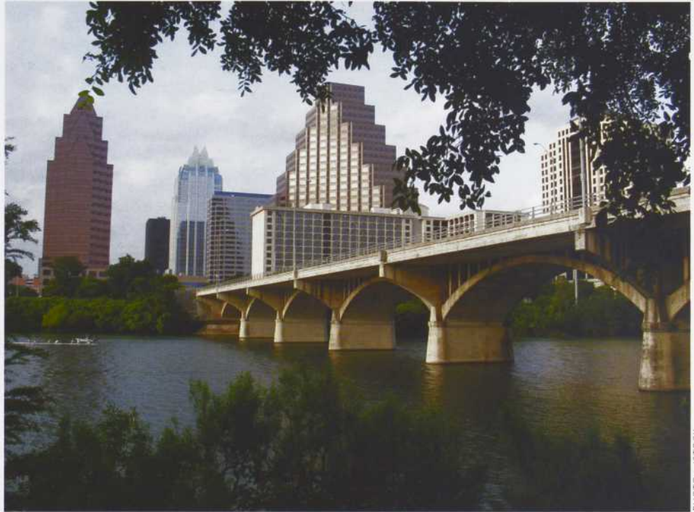
Pont de l'avenue Congress en direction du centre-ville d'Austin, Texas.
