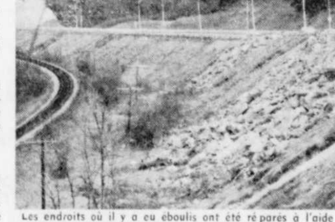
Les endroits où il y a eu éboulis ont été réparés à l'aide de grosses pierres, ce qui ajoute une note discordante au paysage...
