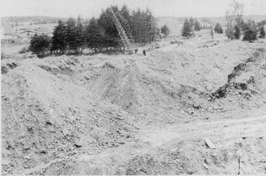
Des travaux de grande envergure sont présentement en cours à St-Georges-Ouest sur le site des Développements Ross. D'imposantes machines creusent des tranchées pour enfouir
