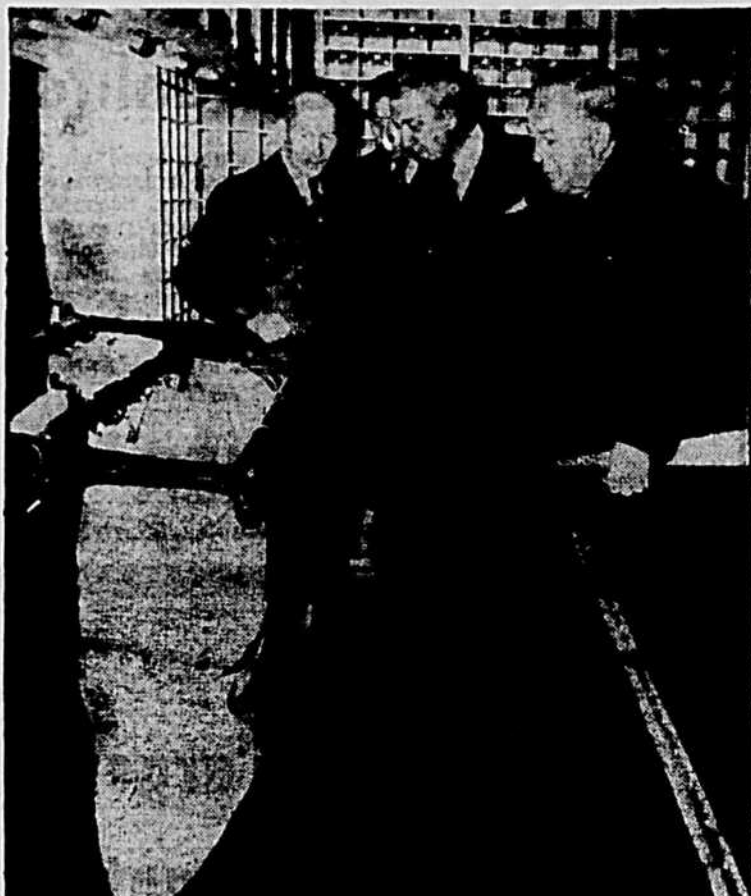
Des hauts fonctionnaires du Canadien National examinent l'équipement moderne d'un nouveau wagon-poste mis en service. Le wagon mesure 30 pieds de long, renferme 360 cases à lettres, 26 boîtes à journaux et 52 supports pour sacs de courrier. Une longue table au centre facilite la manutention des lettres. Sans ces bureaux mobiles, le service postal canadien serait infiniment plus lent.
