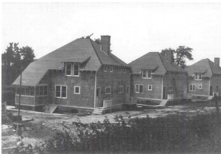
Maisons en construction dans Gardenvale au début des années 1920. Vue de l'arrière.
