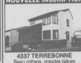
NOUVELLE INSCRIPTION 4337 TERREBONNE Beau cottage, grandes pièces éclairées, walk-in dans 2 c/c, garage porte électrique, paysagé, clôturé.
