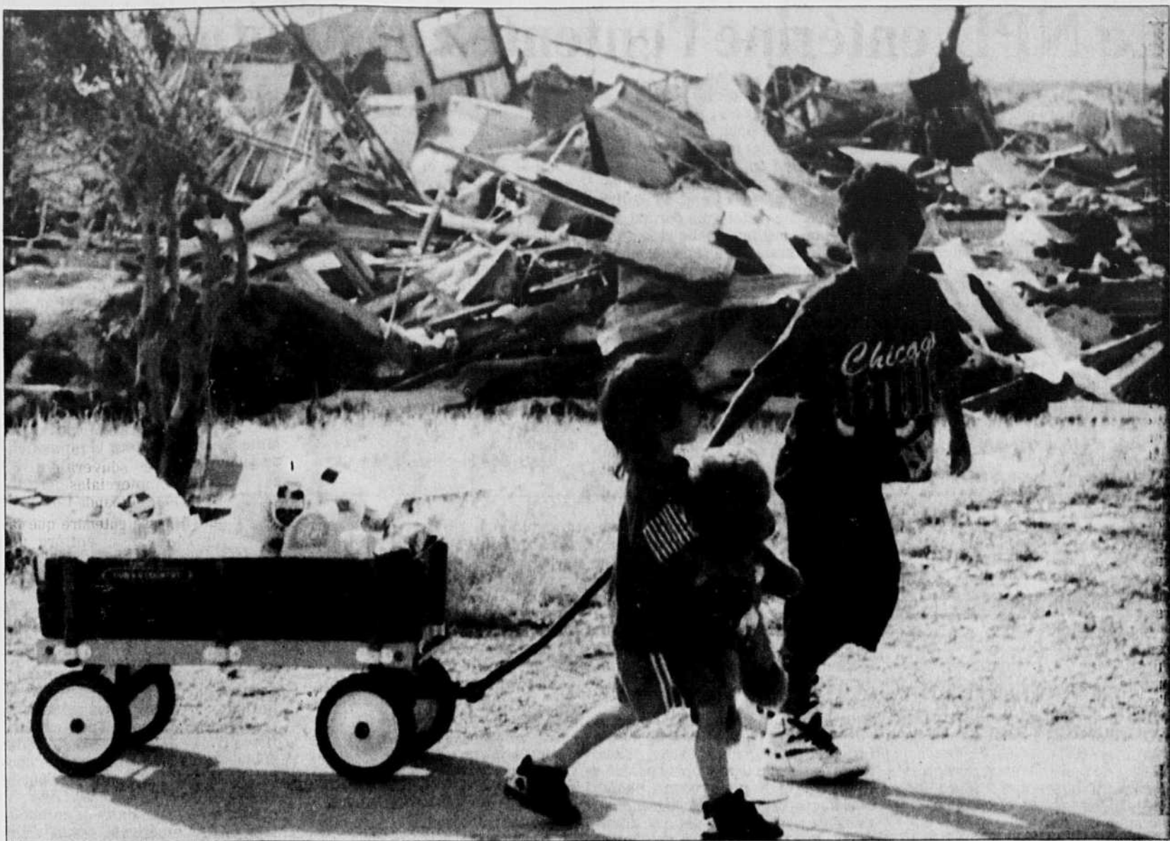
Deux jeunes de Homestead, dans le sud de la Floride, ne semblent pas trop s'en faire des dégâts laissés par l'ouragan Andrew. Derrière eux, une maison qui a été complètement soufflée.
