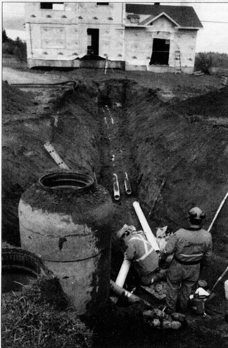
TRAVAUX - Saguenay investira 22,3 millions de dollars au cours des trois prochaines années afin de rénover ses réseaux d'aqueduc et d'égout et d'effectuer la réfection de quelques grandes artères.
