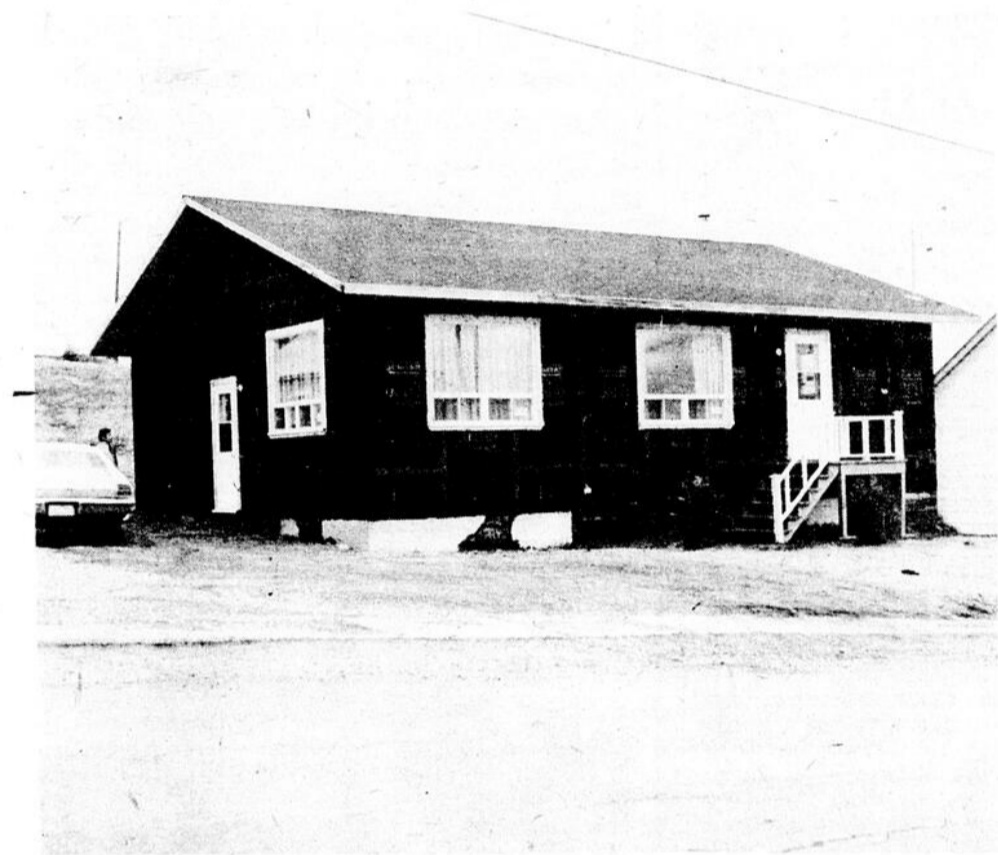
"COOPERATIVE FORESTIERE STE-APOLLINE" La construction du local de la Coopérative forestière de Ste-Apolline est maintenant terminée. "Il ne reste qu'à revêtir l'extérieur", nous apprenait la semaine dernière M. Lucien Bernier, gérant.
