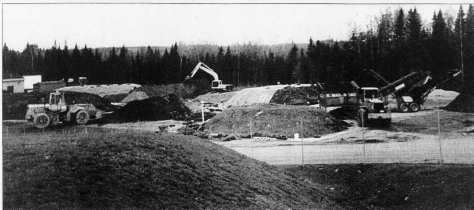
Les stocks de sols contaminés sont recouverts d'une bâche pour en contrôler l'humidité, mêlés à différentes sources de matière organique et régulièrement retournés pour stimuler l'ardeur des microtravailleurs biologiques qui en décomposent les molécules toxiques.
