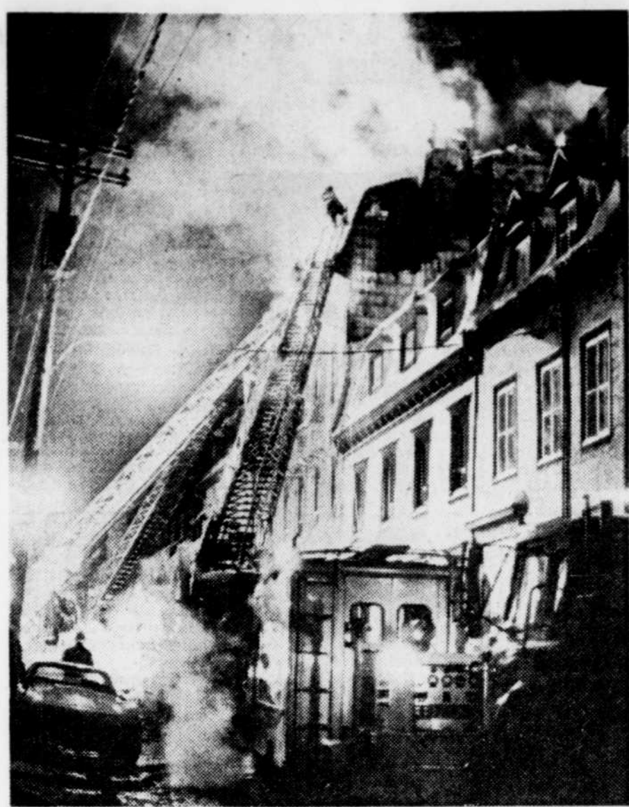
Au plus fort de l'incendie, une fumée dense s'échappait du toit de la conciergerie qui a été endommagée, hier, sur la rue Sainte-Ursule, à Québec. Plusieurs échelles aériennes ont été dressées pour mieux combattre le brasier.
