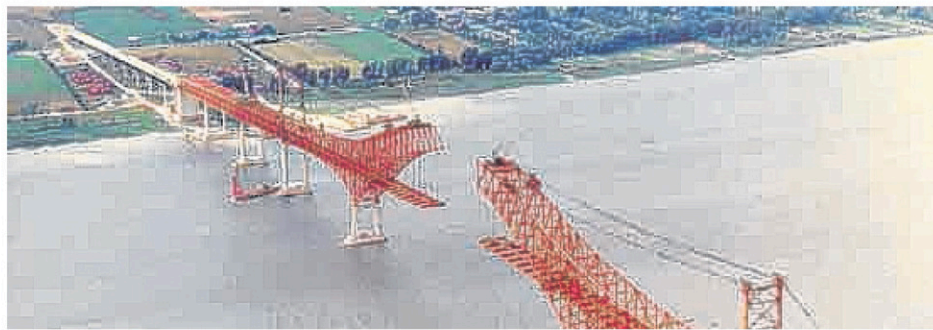
Le pont Laviolette pendant les travaux de construction. La couche de fond était rouge, mais le pont a toujours été peinturé en vert. (Photo gracieuseté - Archives de la Dominion Bridge)
