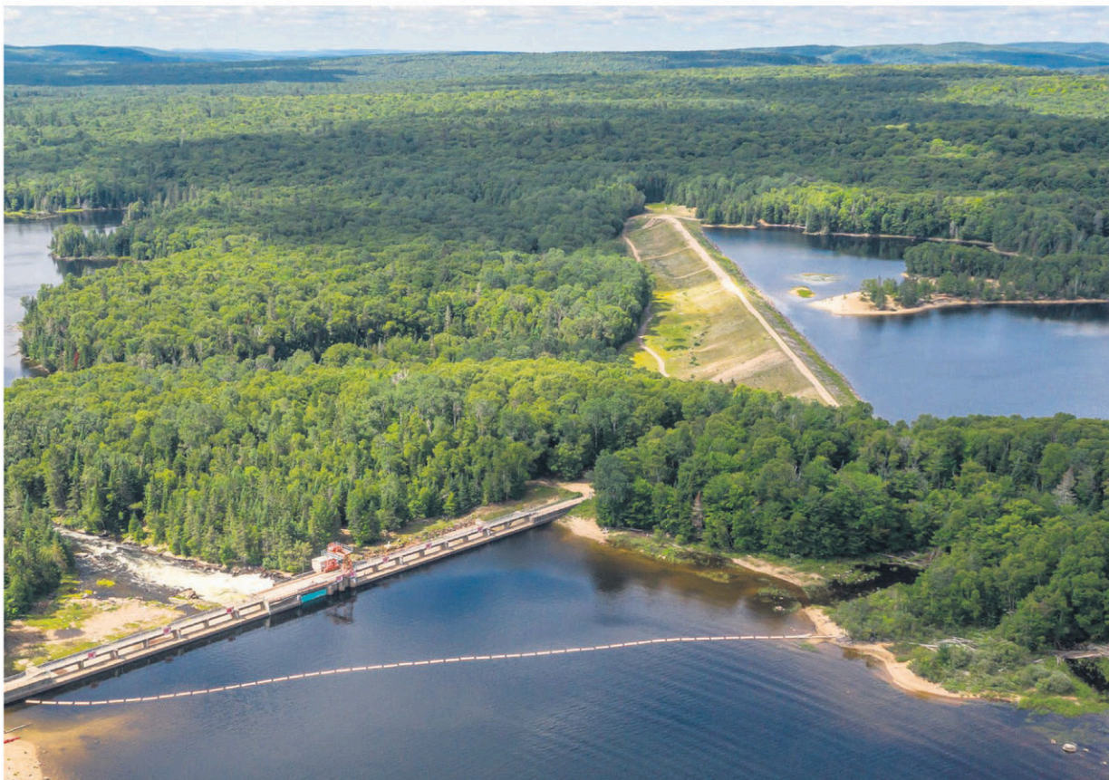
Construite en 1954, la digue Morier est une structure de retenue en terre d'une hauteur de 15,55 mètres, d'une longueur de 678 mètres et d'une capacité de retenue de 382 000 000 m3.
