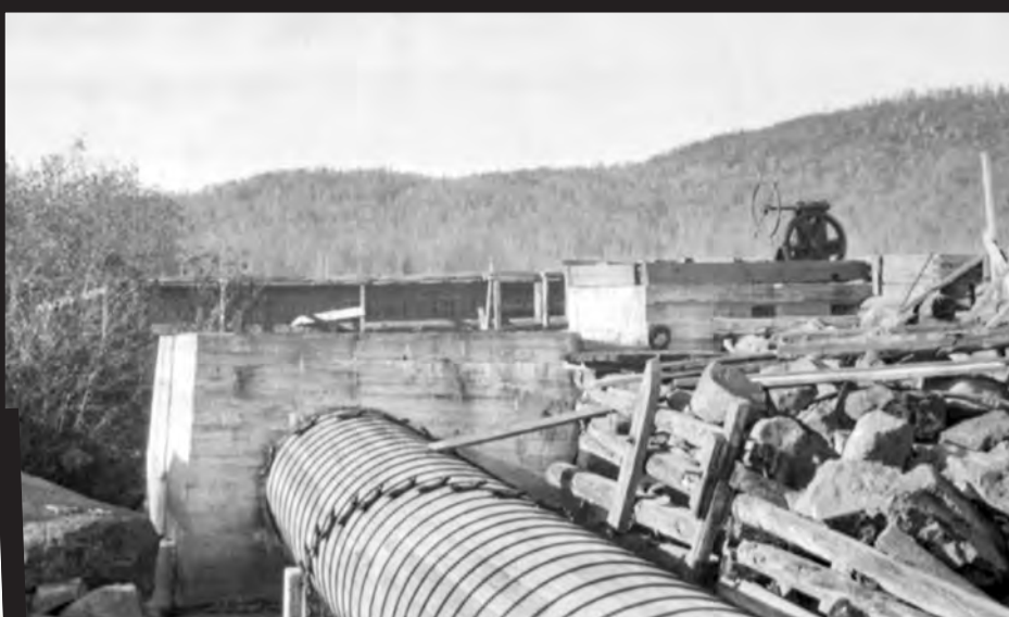
1931, le tuyau d'amenée d'eau aux turbines (qui semblent toujours exister en 1931) du moulin. Fonds ministère du Développement durable, de l'Environnement et de la Lutte contre les changements climatiques, BAnQ, E57,S44,SS1,PB21-32.
