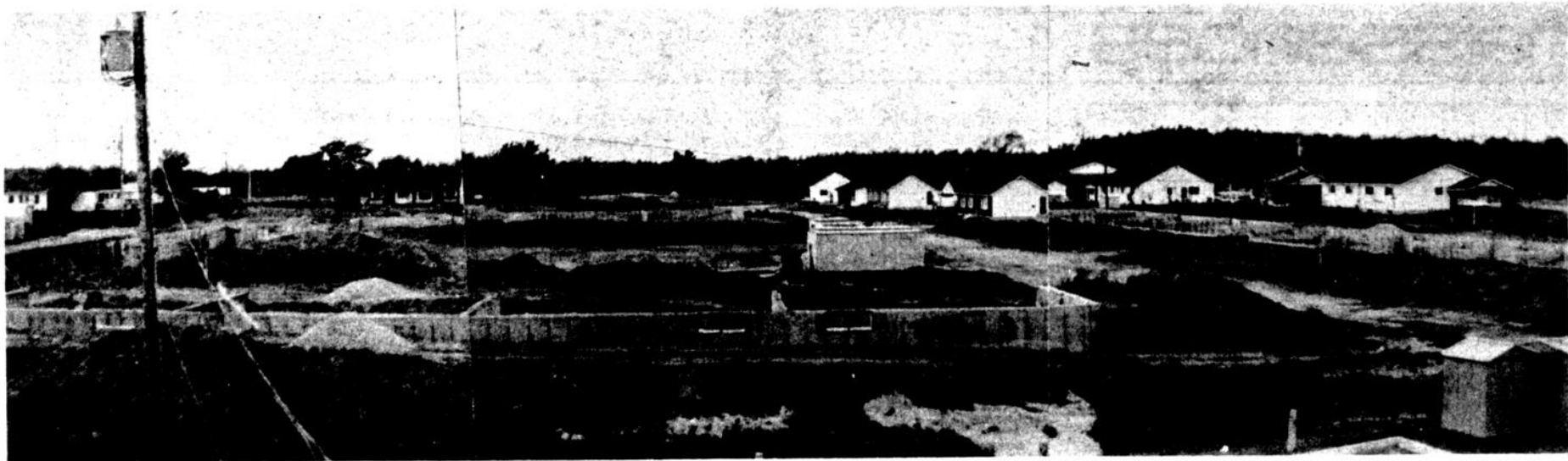
La grève de la construction a paralysé de nombreux chantiers dans la région au cours de 1976.
