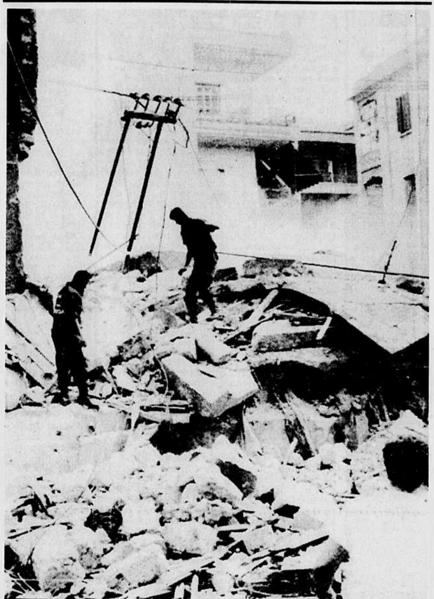
Des sauveteurs libanais s'affairaient autour des ruines d'un bâtiment écroulé à la suite d'un incendie déclenché par la chute d'obus syriens et chrétiens, sur un quartier de Beyrouth.
