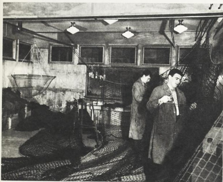
Montage des filets
