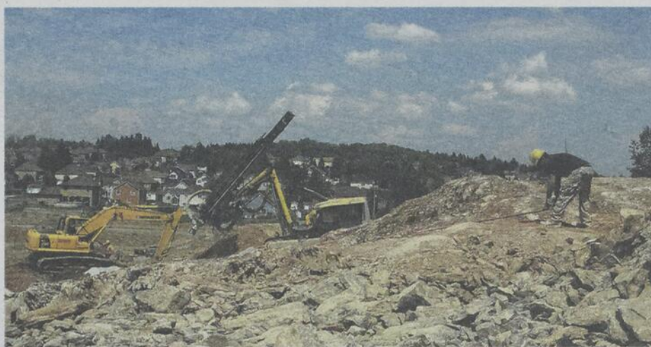
Du dynamitage a eu lieu près des résidences déjà existantes. (Photo TC Media - Jean-François Fecteau)
