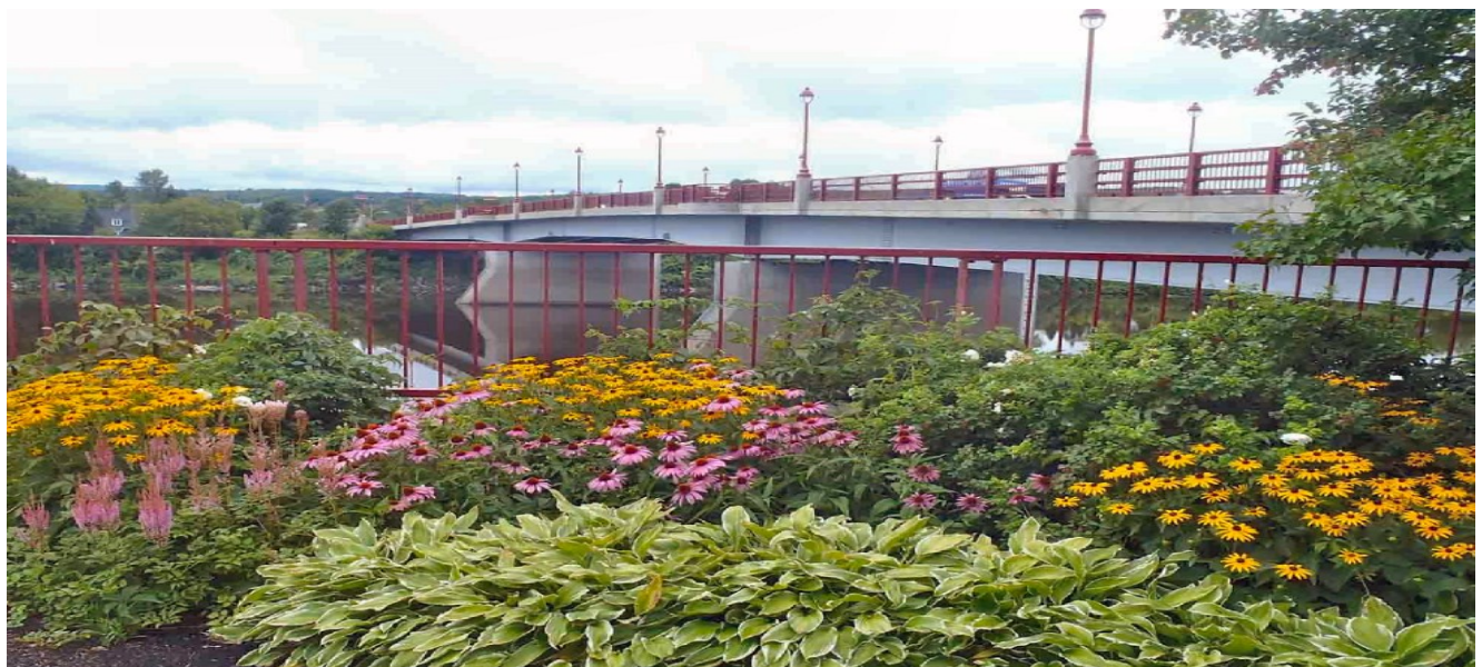
Le pont de Ste-Marie-de-Beauce / The bridge in Ste-Marie-de-Beauce
