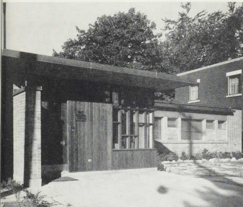
Détail de l'entrée
