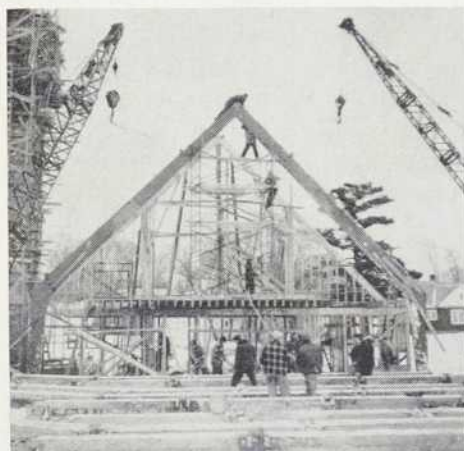
Fig. 1 — Compton. Erection du premier arc.
