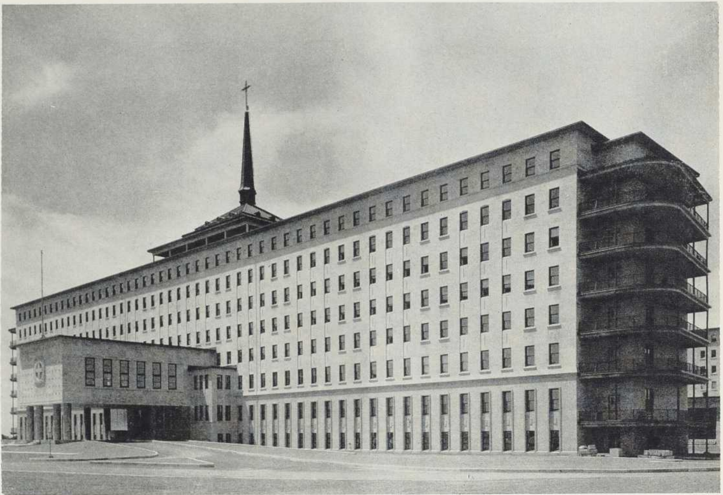
Détail de façade. L'alternance des saillies devient ici plus apparente. On remarque également les deux joints d'expansion à niveau de l'aile centrale.
