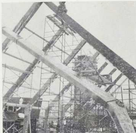
Fig. 2 — Section d'arc en cours de levage.
