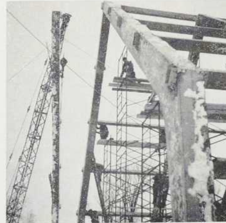
Fig. 3 — On distingue les boîtes métalliques servant à ancrer les pannes de bois.
