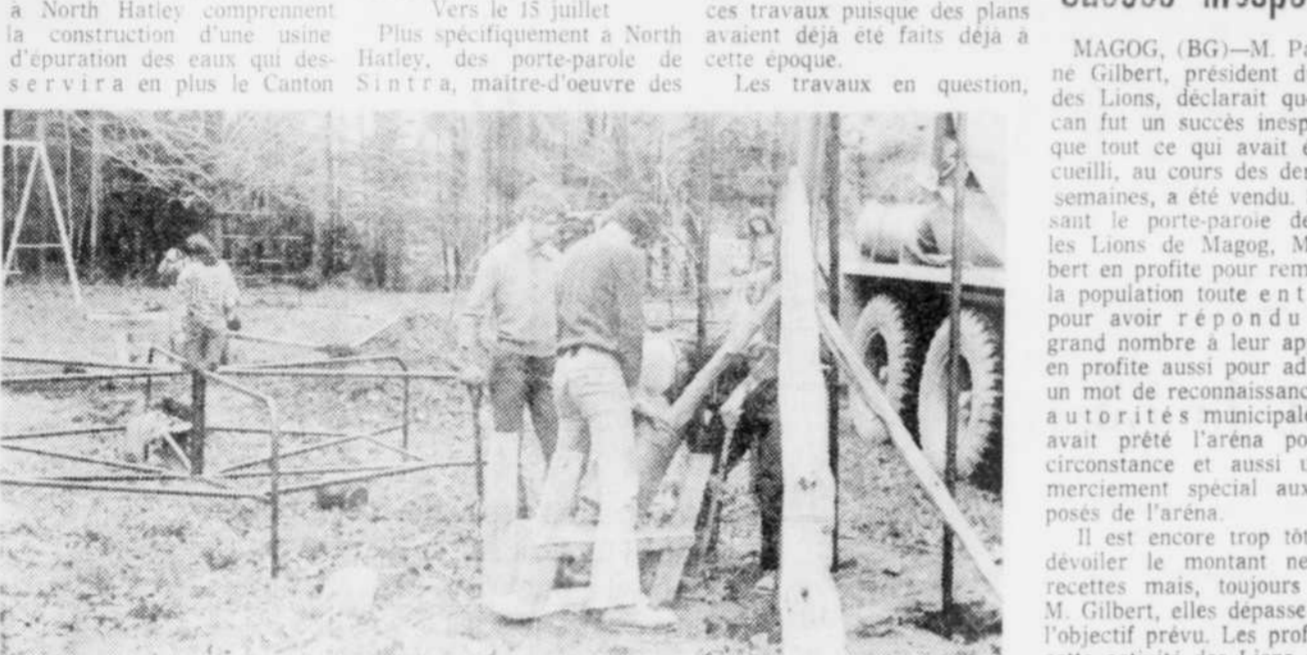
On aperçoit ici les jeunes travailleurs du projet "Sédet" installant les nouveaux jeux au parc situé aux abords de la piscine. (Photo La Tribune, J.L. Valcourt)
