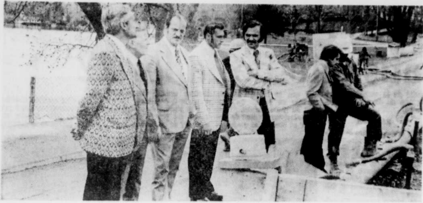
A North Hatley, hier, le ministre Georges Vaillancourt a effectué, lors de l'inauguration officielle, une brève visite des travaux en cours en compagnie de personnes intéressées aux travaux: de gauche à droite, MM. Jean-Jacques Lafond, directeur régional de Sintra, Georges St-Pierre, maire de North Hatley, Georges Vaillancourt, ministre d'état aux Affaires municipales, un autre représentant de Sintra, et M. Wilfrid Morin, de Lemieux, Royer, Donaldson, Field & Associés, étude d'ingénieurs-conseil responsable des plans des travaux. (Photo La Tribune, North Hatley, par Léon Dion)
