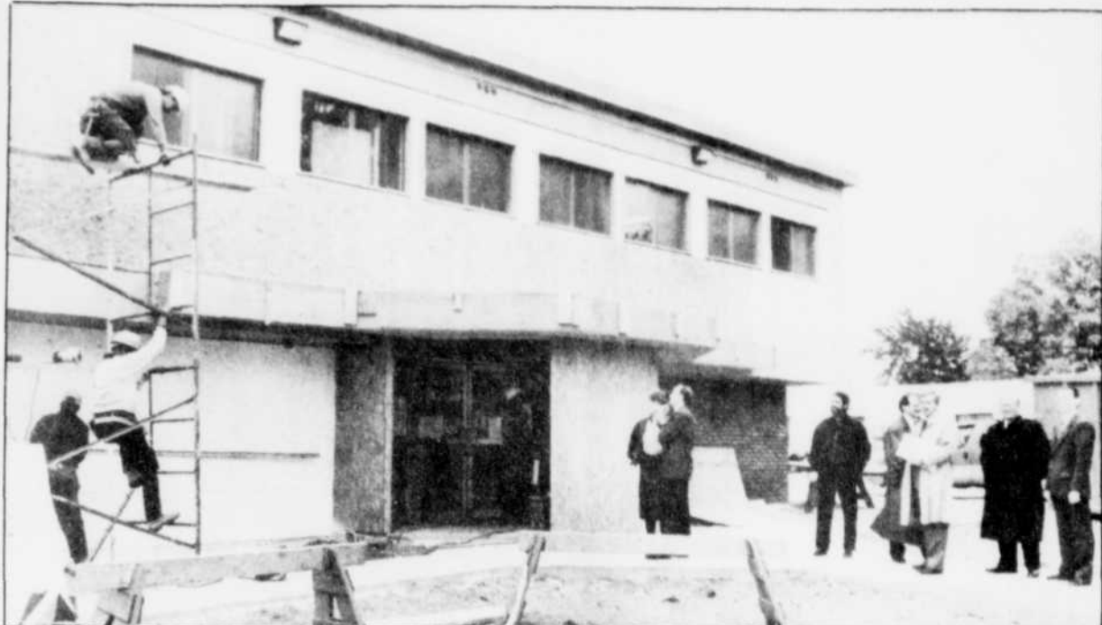
Les travaux de réfection du centre Landry vont bon train. Les architectes de la firme Bluteau & Skorek ont constaté l'évolution du projet en compagnie du maire de Trois-Rivières, M. Guy Leblanc, du conseiller Alain Gamelin, du président du centre Landry, M. Jacques Bourassa, et de son directeur général, M. Antoine Dufour, ainsi que du député de Trois-Rivières, M. Paul Philibert.
