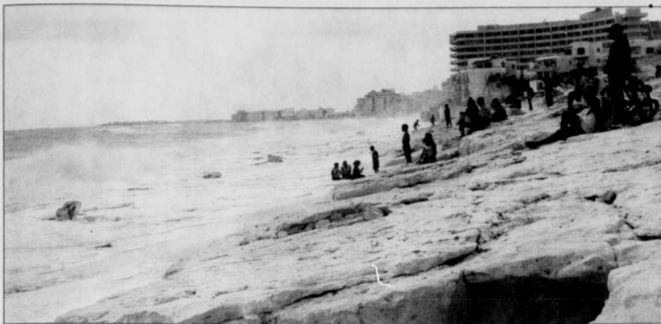
À Cancun, quatre hôtels sur cinq ont été sévèrement endommagés par l'ouragan Wilma. À la mi-décembre, la moitié des établissements hôteliers pourraient être en mesure d'accueillir des touristes.
