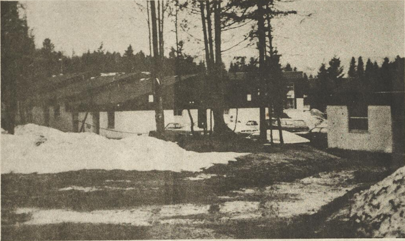
Ces immeubles de Place Ste-Agathe, construits au financement de la Société centrale d'Hypothèques et de Logements, deviendront-ils des logis de luxe? Quelqu'un aurait-il trouvé le coin trop beau pour le "monde ordinaire"?
