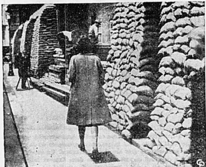
L'Angleterre poursuit frénétiquement l'organisation de sa protection contre les raids d'avions ennemis. Voici un aspect de l'hôpital Westminster de Londres devant la façade duquel des piles de sacs de sable ont été placées pour le protéger des bombes.
