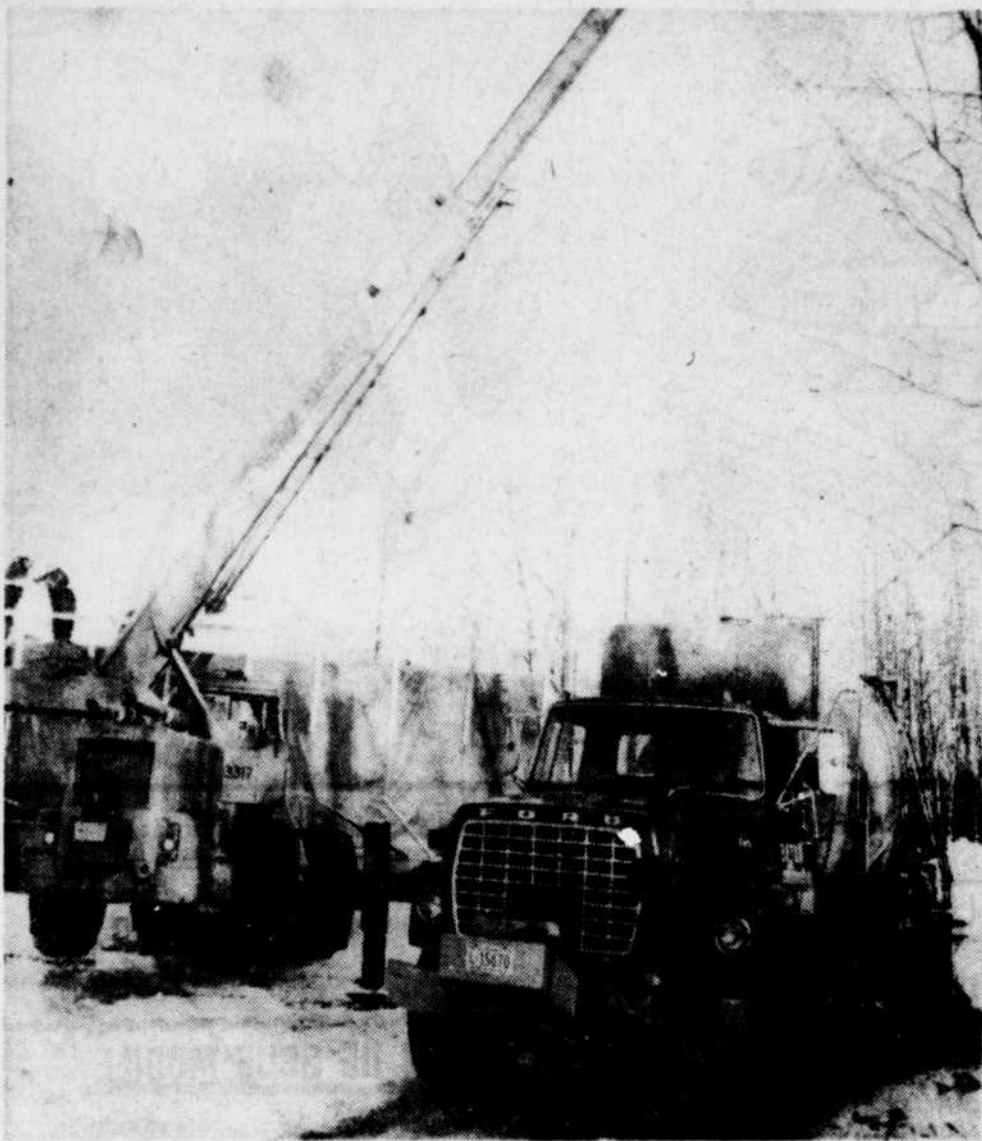
Beaucoup d'activité était observée hier sur le site du Pavillon Lemire à Drummondville-Sud alors que se faisait une grande coulée de béton. L'édifice, qui devrait être complété en août, recevra 36 jeunes de moins de 18 ans qui ont des difficultés de comportement.
