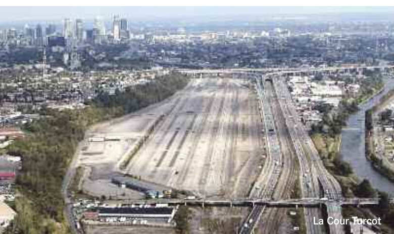
Le Quartier International de Montréal a permis de recouvrir une partie de l'autoroute Ville-Marie et de relier le centre des affaires et le Vieux-Montréal de façon exemplaire.
