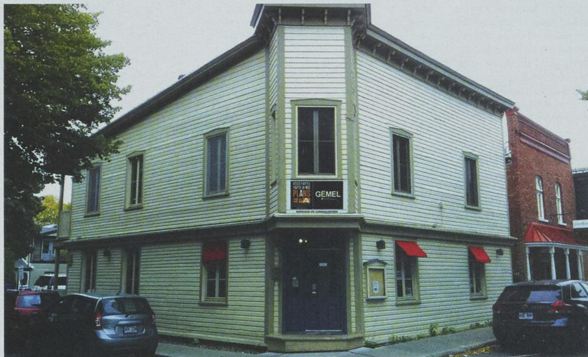
Depuis quelques mois, Gémel et EPA Architecte et associés se sont établis au 195, rue Sainte-Marie dans le Vieux-Terrebonne.
