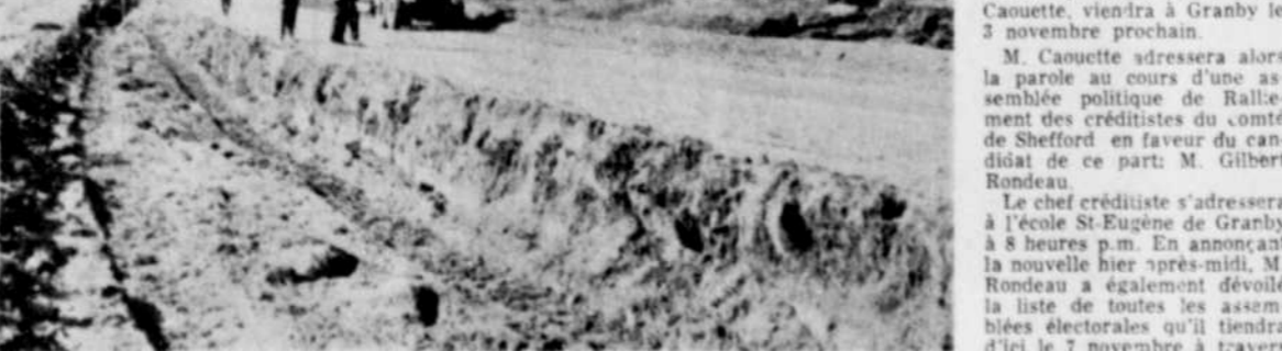
DÉS TRAVAUX ont été entrepris, sur la route 52, à l'entrée de Cowansville dans le quartier de Sweetsburg. La partie de la route qu'on aperçoit sur la photo, sera rehaussée de dix pieds afin de donner à cette route un niveau égal lorsqu'on entrera à Cowansville où l'on en sortira. De plus, en élevant cette route de dix pieds, cette élévation servira en même temps d'accotement au futur bassin qui se trouvera à gauche de la photo.
