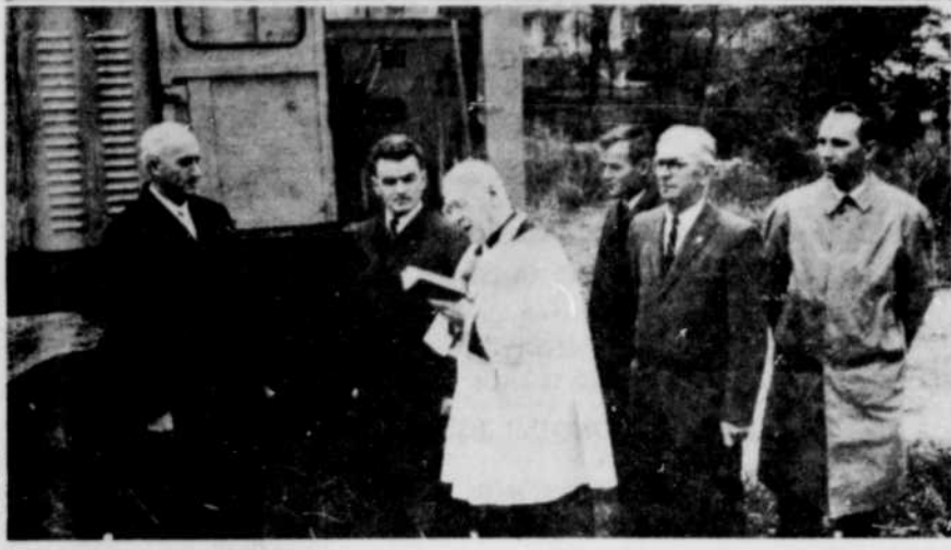
DEBUT DES TRAVAUX. — Le chanoine Lorenzo Ferland de Danville procède ici à la bénédiction du terrain où s'élèvera bientôt l'immeuble logeant la Caisse populaire. On remarque également sur le cliché, dans l'ordre habituel, M. Gérard Lafrance, maire de Danville, M. Paul-Emile Pomerleau, M. Maurice Champagne, M. Elphège Comeau, président de la Caisse et M. Hubert Couture, géant.
