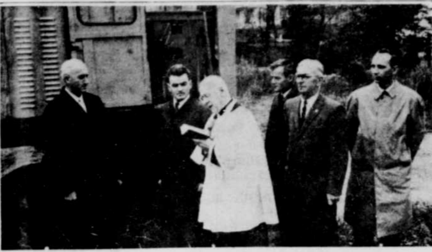
DEBUT DES TRAVAUX. — Le chanoine Lorenzo Ferland de Danville procède ici à la bénédiction du terrain où s'élèvera bientôt l'immeuble logeant la Caisse populaire. On remarque également sur le cliché, dans l'ordre habituel, M. Gérard Lafrance, maire de Danville, M. Paul-Émile Pomerleau, M. Maurice Champagne, M. Elphège Comeau, président de la Caisse et M. Hubert Couture, gérant. (Photo Le Tribune, par Jacques Drapeau)
