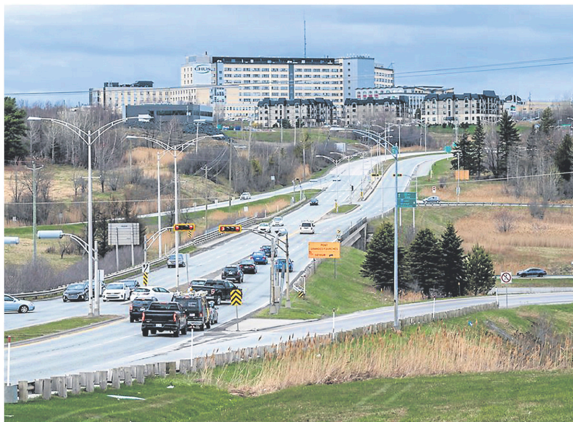
Des travaux d'importance sont prévus pour la construction d'une piste cyclable à l'intersection la 12 e Avenue et de l'autoroute 610. — PHOTO LA TRIBUNE, JESSICA GARNEAU
