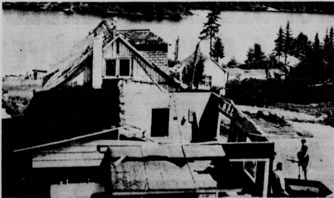
L'épicerie-restaurant, au premier plan, n'a pas résisté à la trombe; la maison construite en rondins, au second plan, était plus solide.
