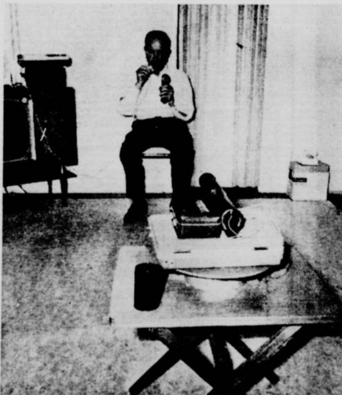
Joseph M. SAMSON expérimente son invention. A côté de lui, le premier magnétophone auquel est relié le projecteur qu'il tient en main. En face, le second magnétophone muni de son "energiseur" et de son récepteur de lumière (tube noir).
