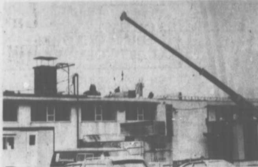
Les travaux de réfection de la toiture de l'école Notre-Dame à Terrebonne sont commencés depuis 15 jours maintenant. La toiture nécessitait des réparations majeures car elle laissait s'écouler l'eau dans les classes et le gymnase. (Photo: ANDRÉ CÔTE, LA REVUE)
