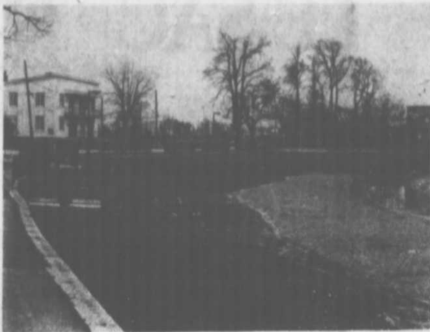
Le pourtour de l'étang Masson a été comblé de terre afin que soit consolidé le muret qui contient les eaux. Ces travaux se font simultanément avec ceux du barrage d'alimentation de l'étang Masson. [Photo: LA REVUE]
