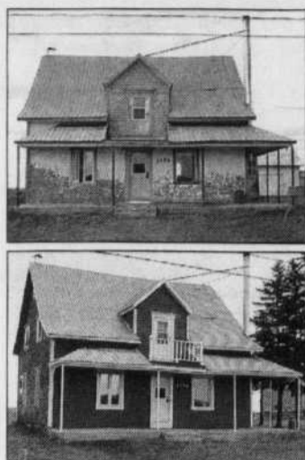
Avant et après... Maison rénovée avec l'aide du SARP.
