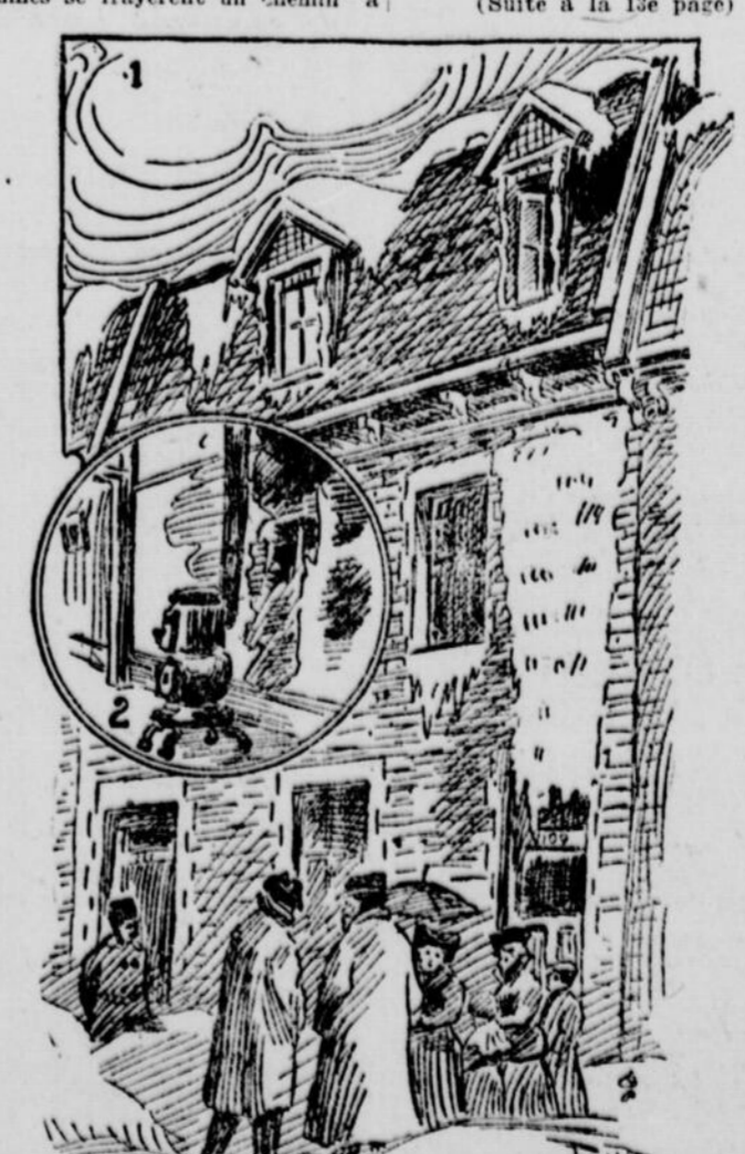
Vue de l'immeuble incendié, hier, sur la rue Lusignan: 1o Dégâts causés par le feu au dernier étage; 2o le poêle qui a mis le feu au mur du logement situé au premier.
