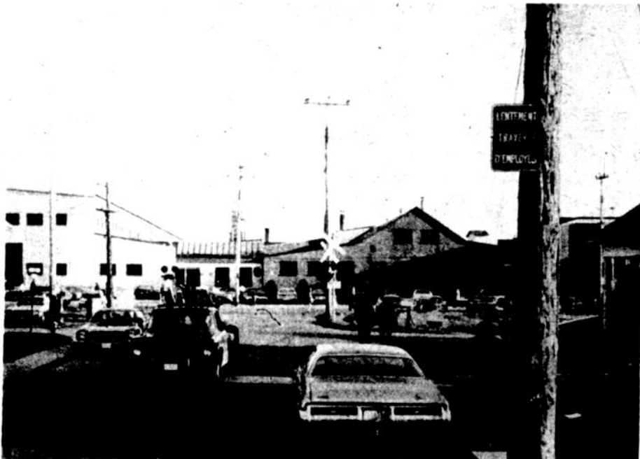
TRAVERSES D'EMPLOYÉS. — Il y a toutes sortes de traverses au Québec. Celles que l'on rencontre le plus souvent sont
