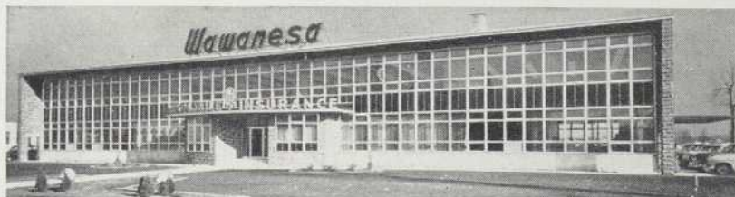
Compagnie d'Assurance Automobile Wawanesa, Montréal, P.Q. Architecte: Leslie A. Perry. Entrepreneur: Walter S. Haut.
