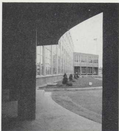
Détail de façade pris sous le porche central.
