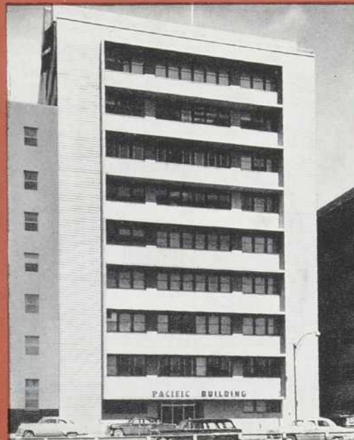
Immeuble Pacific Petroleum Architectes : Rule, Wynn & Rule Entrepreneur général : Burns & Dutton Concrete & Construction Co.
