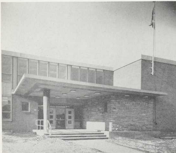
Détail de l'entrée principale.
