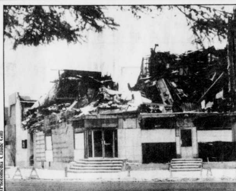
Démolition prochaine de l'hôtel des Chutes
