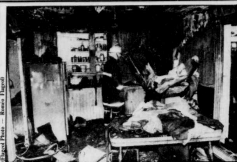
L'appartement de la victime a été passablement endommagé par les flammes.
