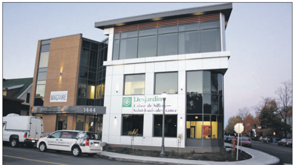
Le nouveau siège social de la Caisse Desjardins Sillery-Saint-Louis-de-France du 1444 de l'avenue Maguire.
