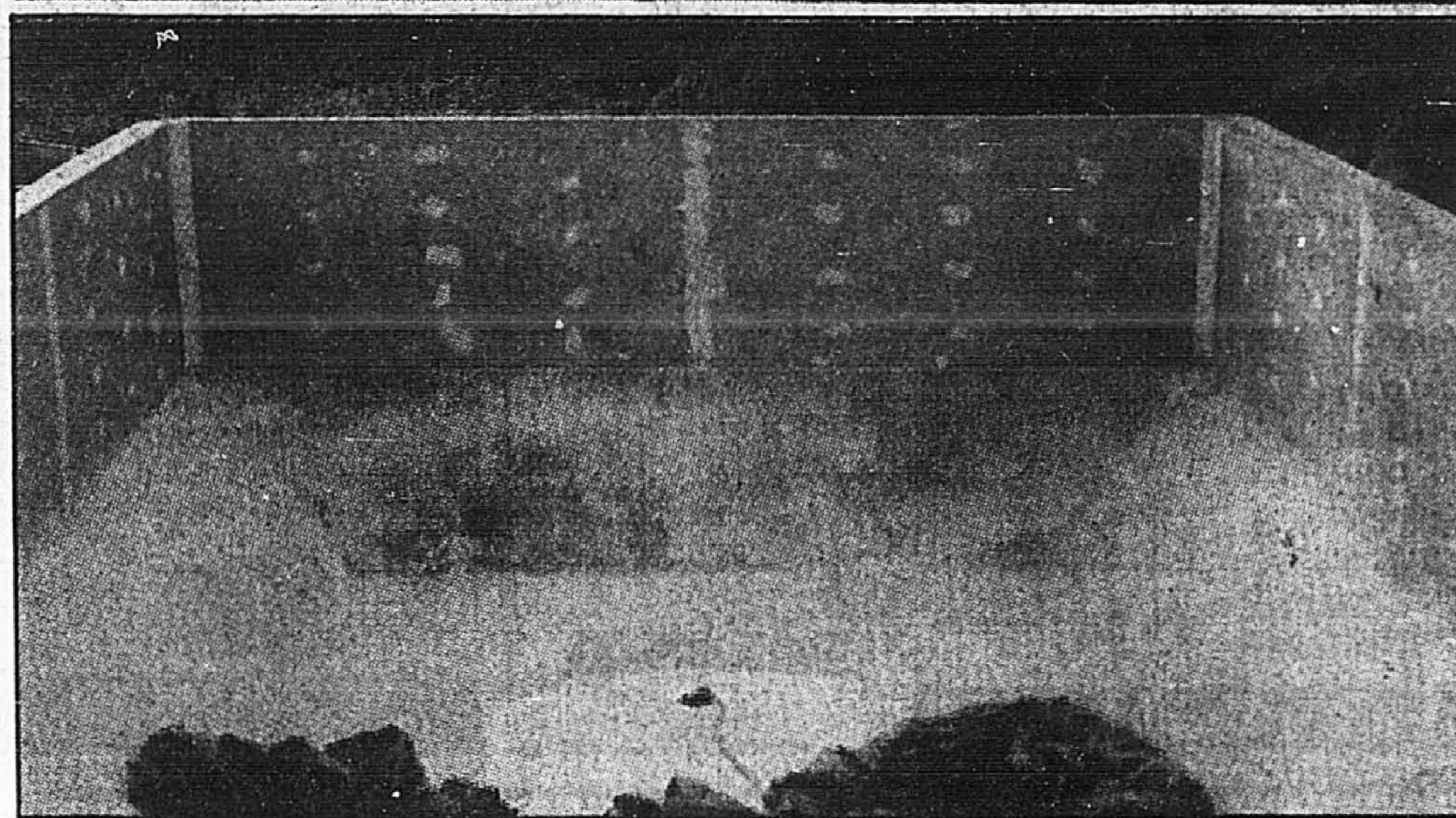
Une fois les murs terminés et le fond cimenté, il ne reste plus qu'à installer la toile de vinyle, déjà taillée aux dimensions de la piscine.
