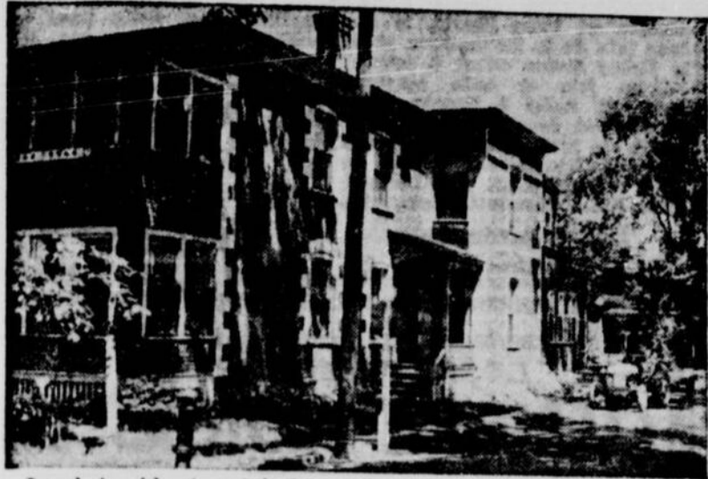
La photo ci-haut sert à deux fins. Elle nous montre d'abord où demeure, avec sa famille, la seconde des héritières de M. Napoléon Bélanger, Mme Labossière, et elle nous indique aussi où M. Bélanger a fait ses études primaires. La maison est, en effet, l'ancienne école de Saint-Pie-de-Bagot. (Photo ACE, par René-S. Lefebvre)
