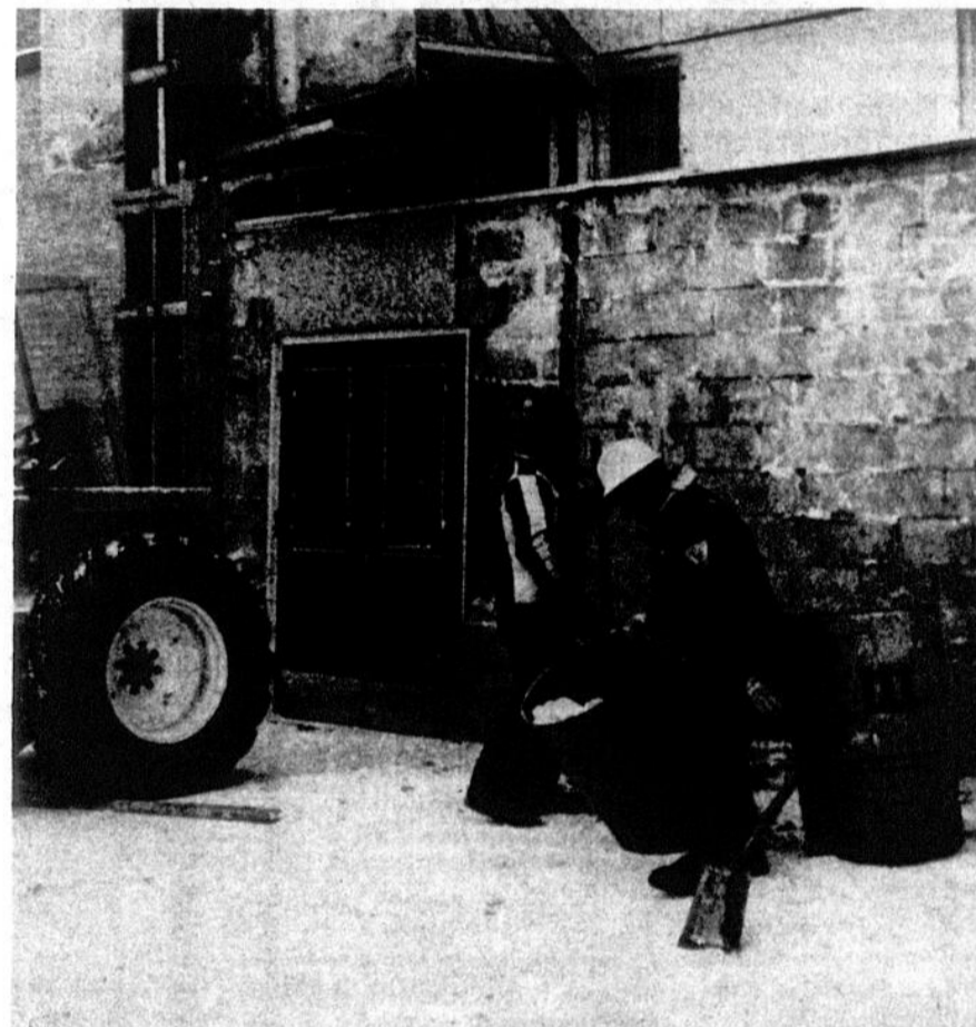
Lundi en après-midi... La moitié du mur est dégagée de la MIUF à l'école Mgr Grenier.
