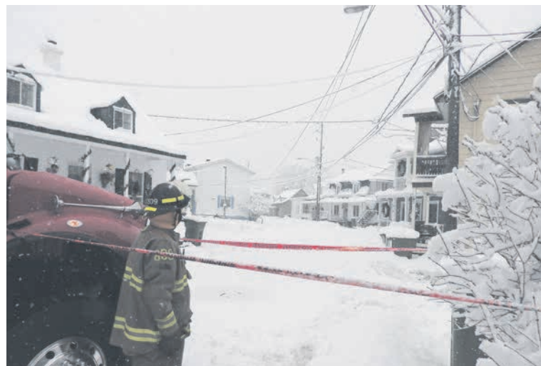
Le poids de la neige a causé la chute d'un fil. Plus de 1000 clients d'Hydro-Québec ont perdu le service. (Photo : Dave Kidd)
