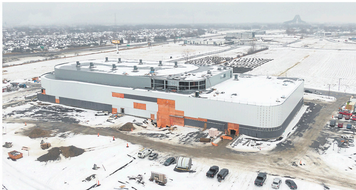
Les travaux de 53,6 millions $ se poursuivent au nouveau colisée de Trois-Rivières. — PHOTO: STÉPHANE LESSARD
