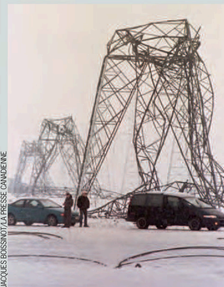
Image surréaliste? Les pylônes tordus sous le poids du verglas. Nous sommes en janvier 1998.
