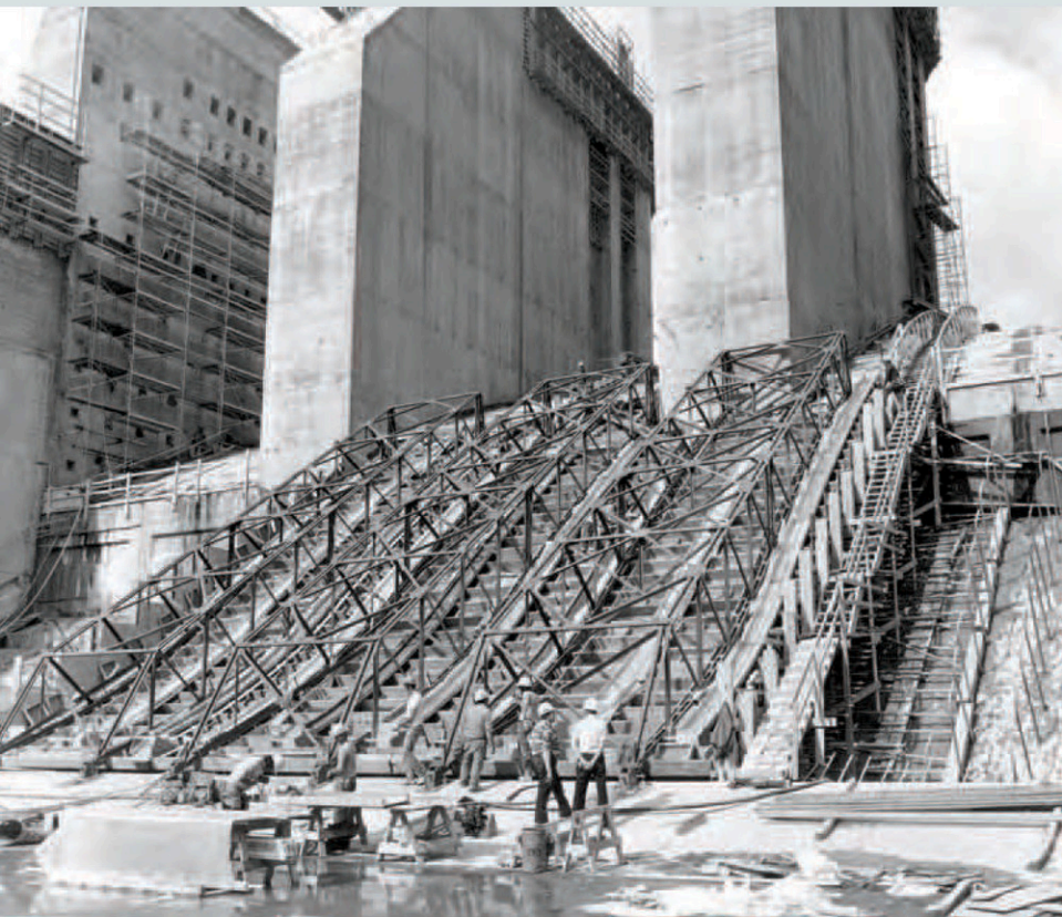
Évacuateur des crues de LG-2 à la baie James, un autre ouvrage dans la tradition du gigantisme d'Hydro-Québec
