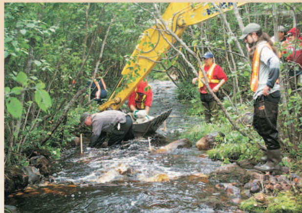
Aménagement d'une frayère à ombre de fontaine
