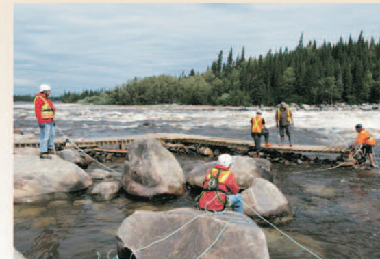
Travaux d'aménagement au site de Smokey Hill
