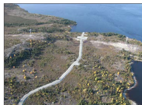
Rampe de mise à l'eau Boyd aménagée sur le terrain VC22
