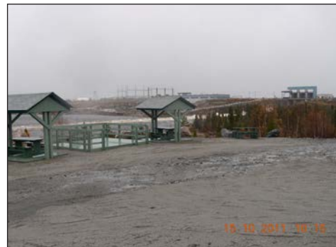
Nouvelle halte d'observation de la MBJ à proximité de la centrale de la Sarcelle
