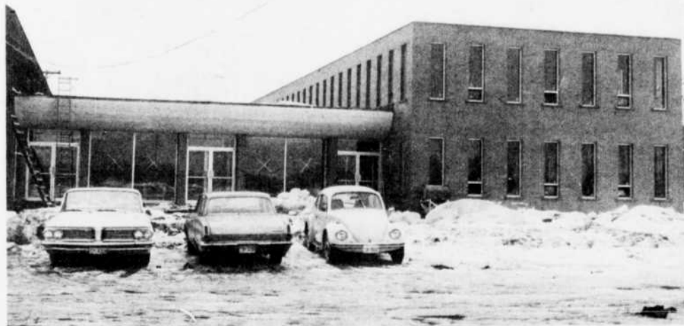
COUP D'OEIL sur l'extérieur de l'immeuble du Personnel qu'on érige entre le quartier de la Sûreté et le bureau principal de l'Alcan d'Arvida.
