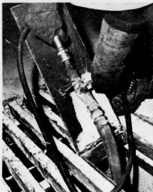
L'UNE DES PIECES ESSENTIELLES pour le bon fonctionnement du costume ventilé, c'est la prise d'air que l'on retrouve à tous les cinquante pieds environ, dans les ventilateurs des allées centrales des salles de cuves. A noter que cet air spécial qui entre dans le costume et que l'employé respire est un air filtré.
